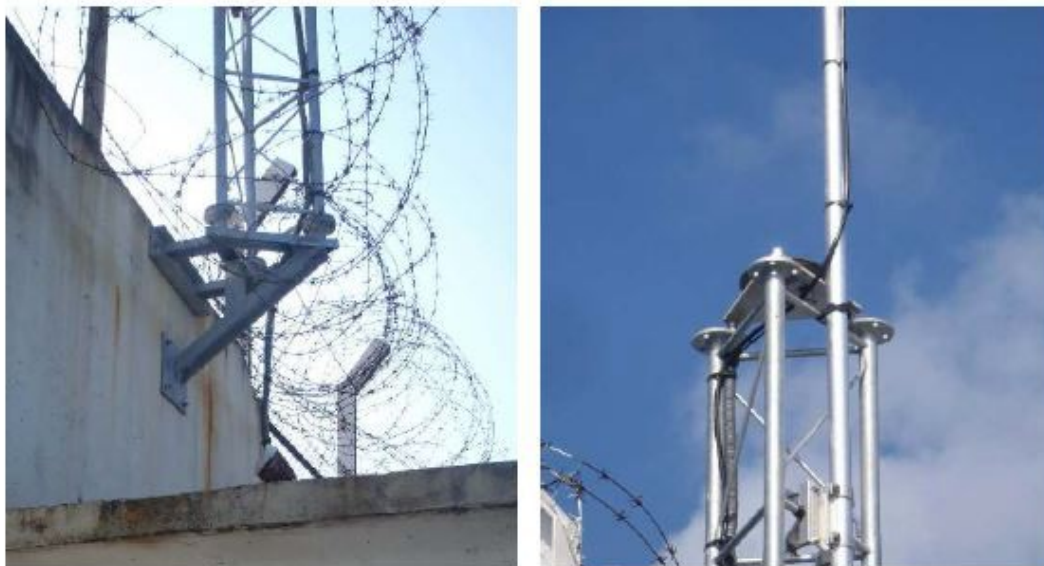
Vue des parties inférieures et supérieures du pylône de support
